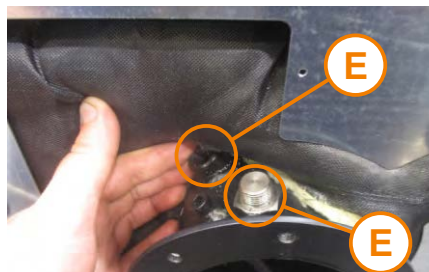
3.16. Maknite izolaciju kotla (D) te demontirajte čep (E) priključka Lambda sonde (F)
