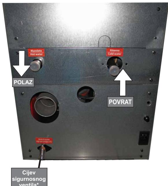
\* Na cijev sigurnosnog ventila spojiti lijevak za otjecanje (slika) ili sl. te ju spojiti na kanalizaciju. Cijev mora izdržati pritisak temperature.
