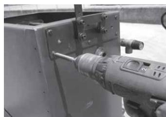
Nakon čišćenja gornjeg djela kotla, postaviti nazad poklopac koji je fiksiran sa vijcima te pričvršćen keramičkim konopom, koji garantira savršenu zatvorenost te nema ulaska zraka. Čišćenje se u principu radi na kraju sezone, provjeriti i sve ostale dijelove.
