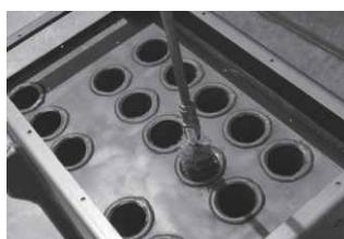
Prije čišćenja potrebno je izvući turbulatore iz cijevi. Turbulatori se samo izvade iz horizontalnog klina gdje su zakačeni.
