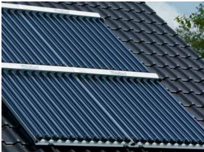
Cijevni kolektori montirani na kosi krov
