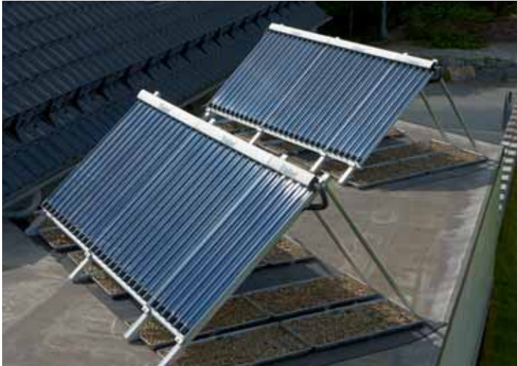
Cijevni kolektori montirani na ravni krov
