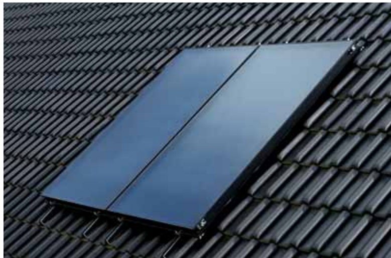
Pločasti kolektori montirani na kosi krov
